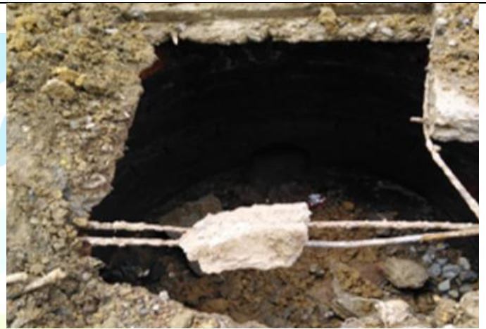
Demolicion de camaras
