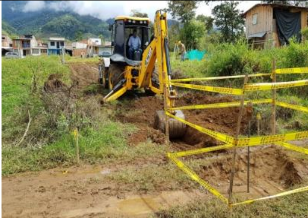
Excavación zanja
