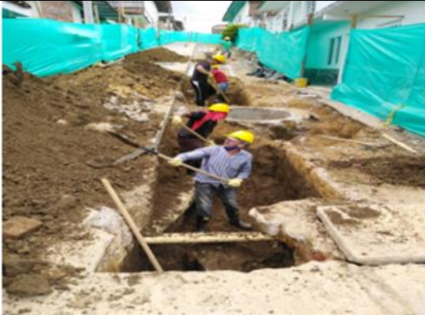
Excavacion entre cámaras de tramos 1ALL y 5 ALL
