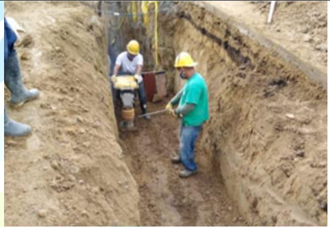
Llenado con material de sitio compactado tramos 1ALL y 5 ALL
