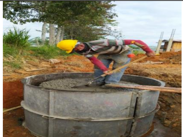
Fundición cámara
