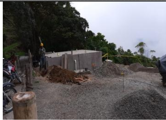
Foto Tanque de Almacenamiento Acueducto Interveredal Argelia
