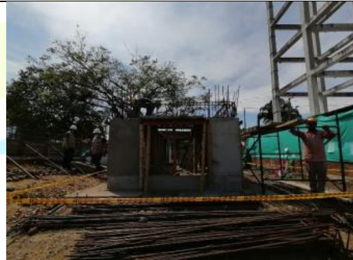
Tanque de aireación
