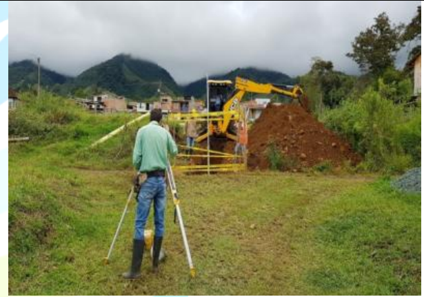
Control topografico nivel excavación
