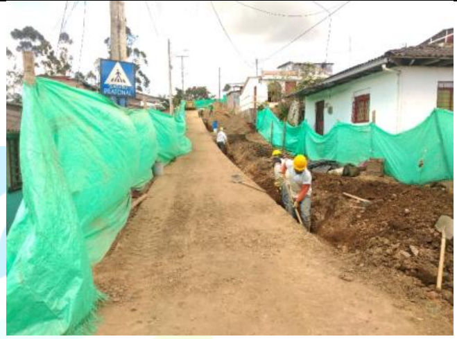
Vista a la obra 15 julio 2020
