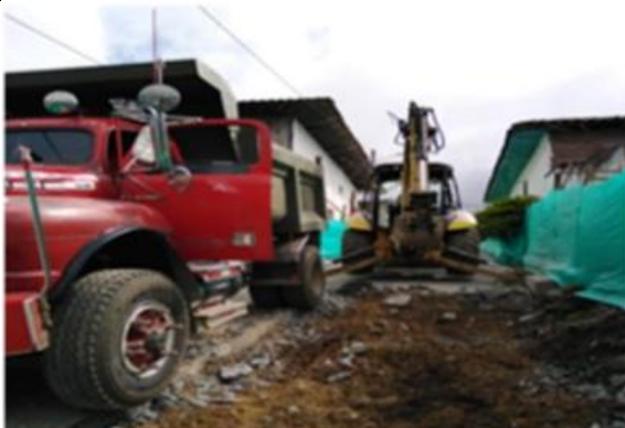
Demolicion de losas
