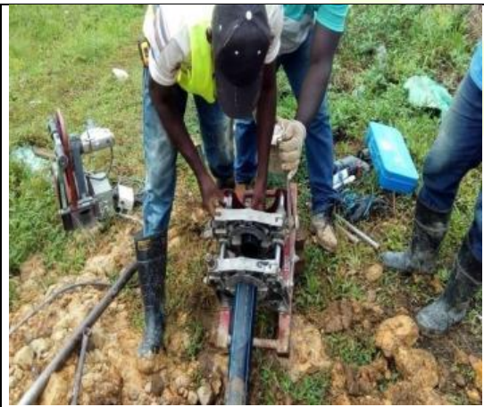
Tubo instalado en Citronela
