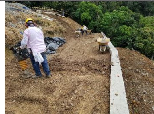
Foto Construcción Muro de Contención Acueducto Interveredal Argelia
