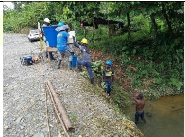
Lleno de tubería para prueba hidráulica
