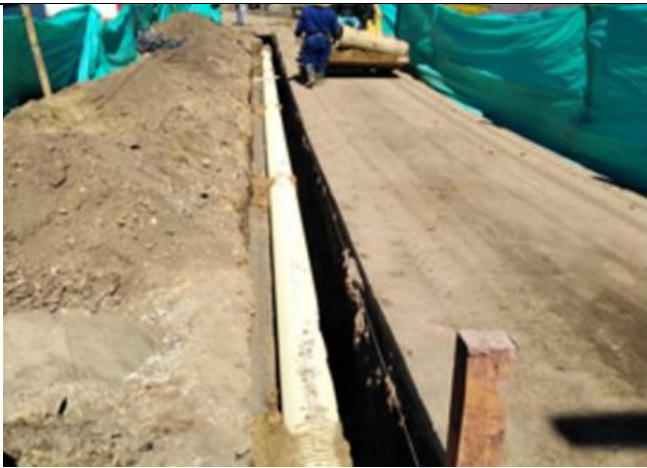
Instalacion de tuberia de 16" PVC sanitaria
