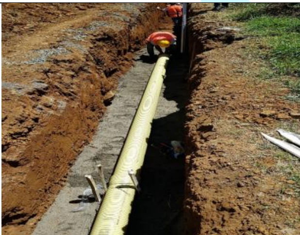
Instalación tubería novafort 8" sobre relleno
