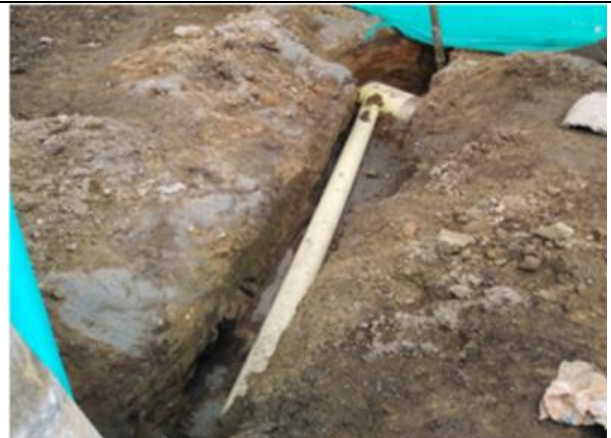
Insalcion tub. PVC san de 6" en acometidas
