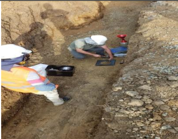
Ensayo densidades materiales relleno rocamuerta
