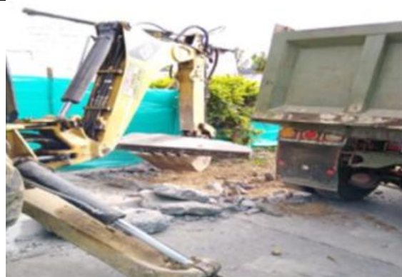
Cargue de escombros
