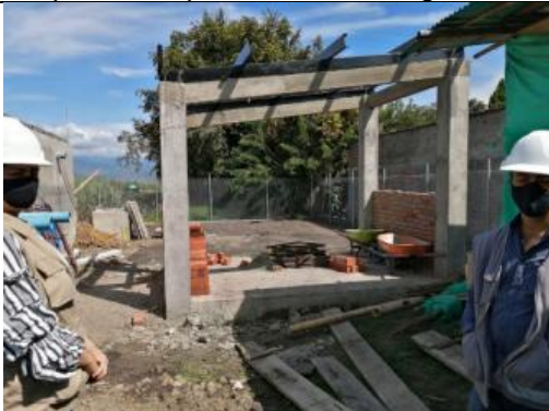
Caseta de bombeo
