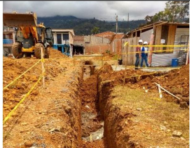
Vista a la obra 23 julio 2020
