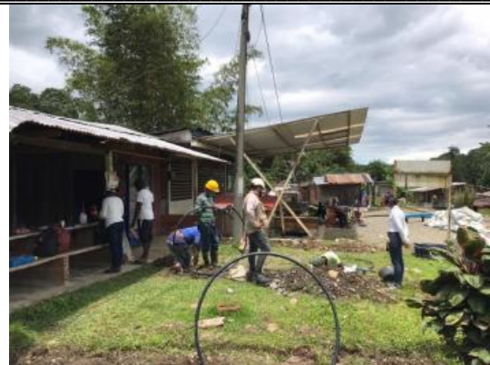
Instalación de acometidas en el Centro Poblado de San Cipriano
